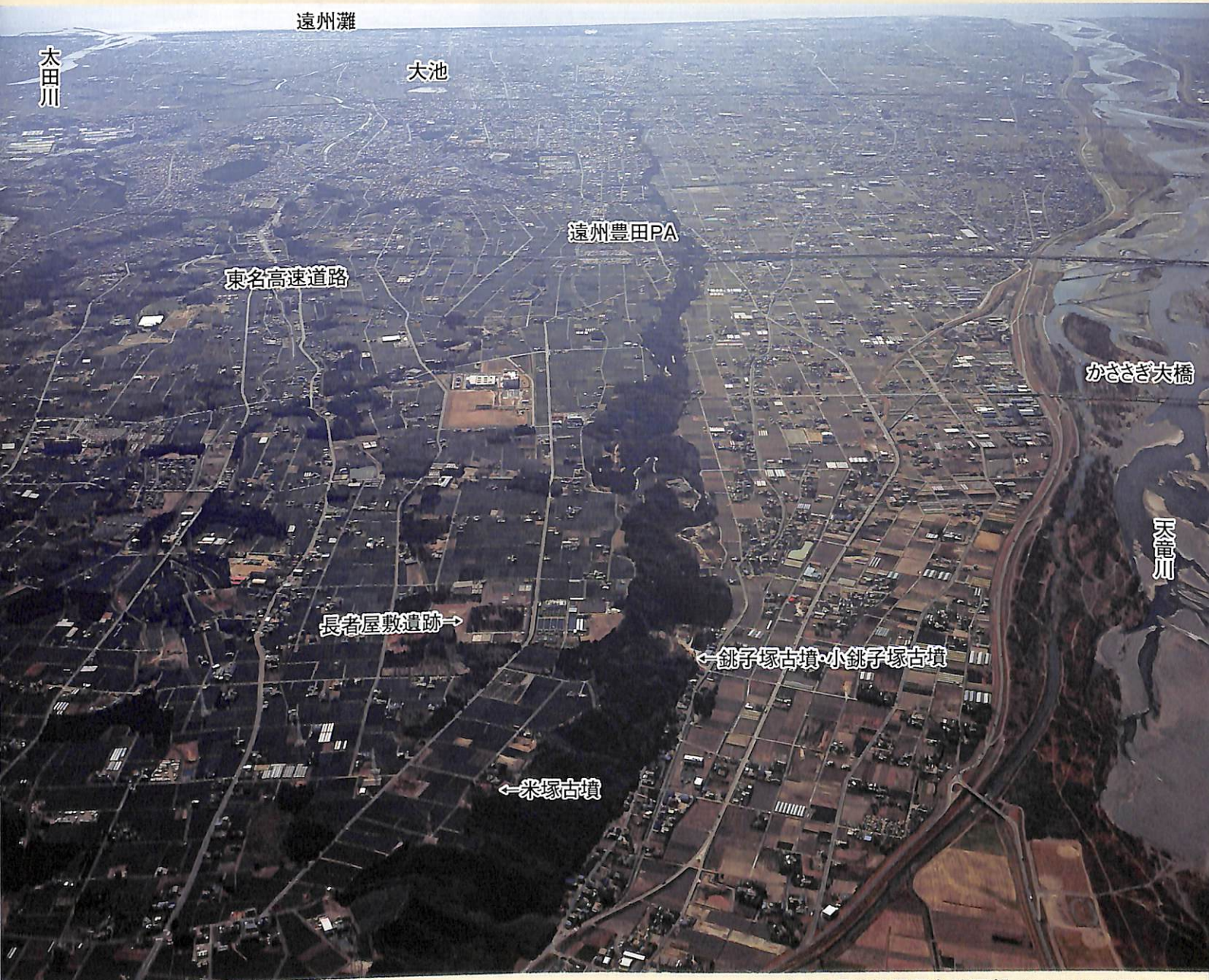
北から見る磐田原台地西部 (平成13年2月撮影)
