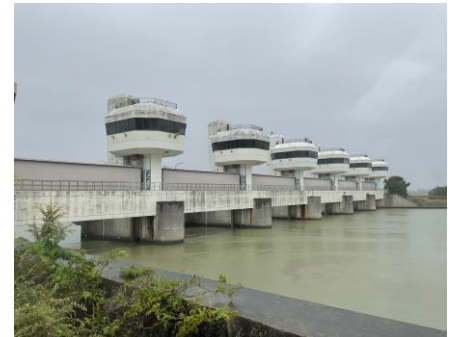
仿僧川耐震水門(2024年撮影)
